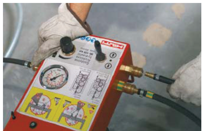
Pressluftleitungen am Bedienpult anschliessen
