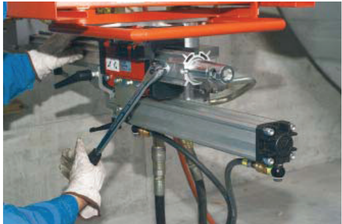
Verbindungskonus einstecken und mit Exzenterbolzen klemmen
